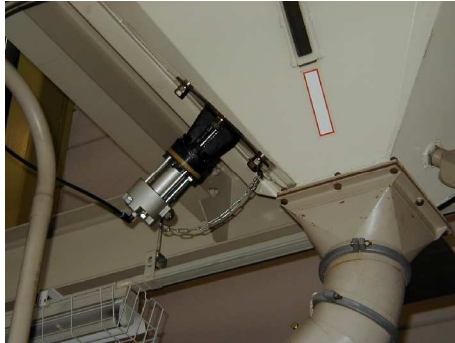
18. エアーノッカー タンクの下部に取り付けられています。定期的に振動を与え、糠を落とします。
