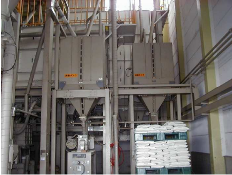
7. 玄米タンク 玄米の貯留タンクです。
